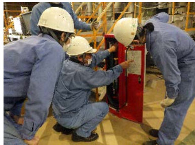
本社エリア：アルミ溶解炉消化訓練
