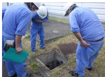
雨水溝への流出状況確認
